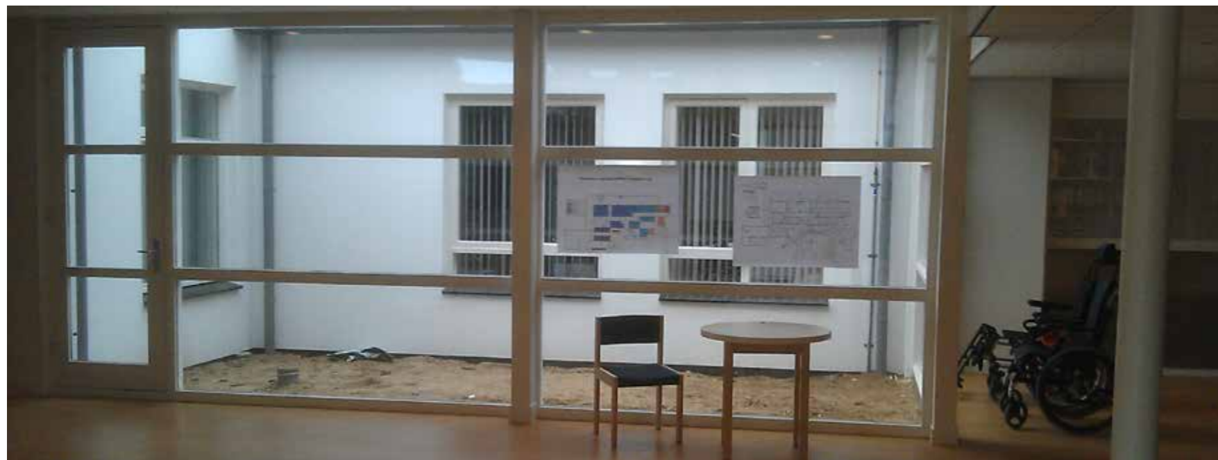
Verbouwen van de bestaande vleugel van een zorgcomplex tot Centrum voor Complexe Zorg
