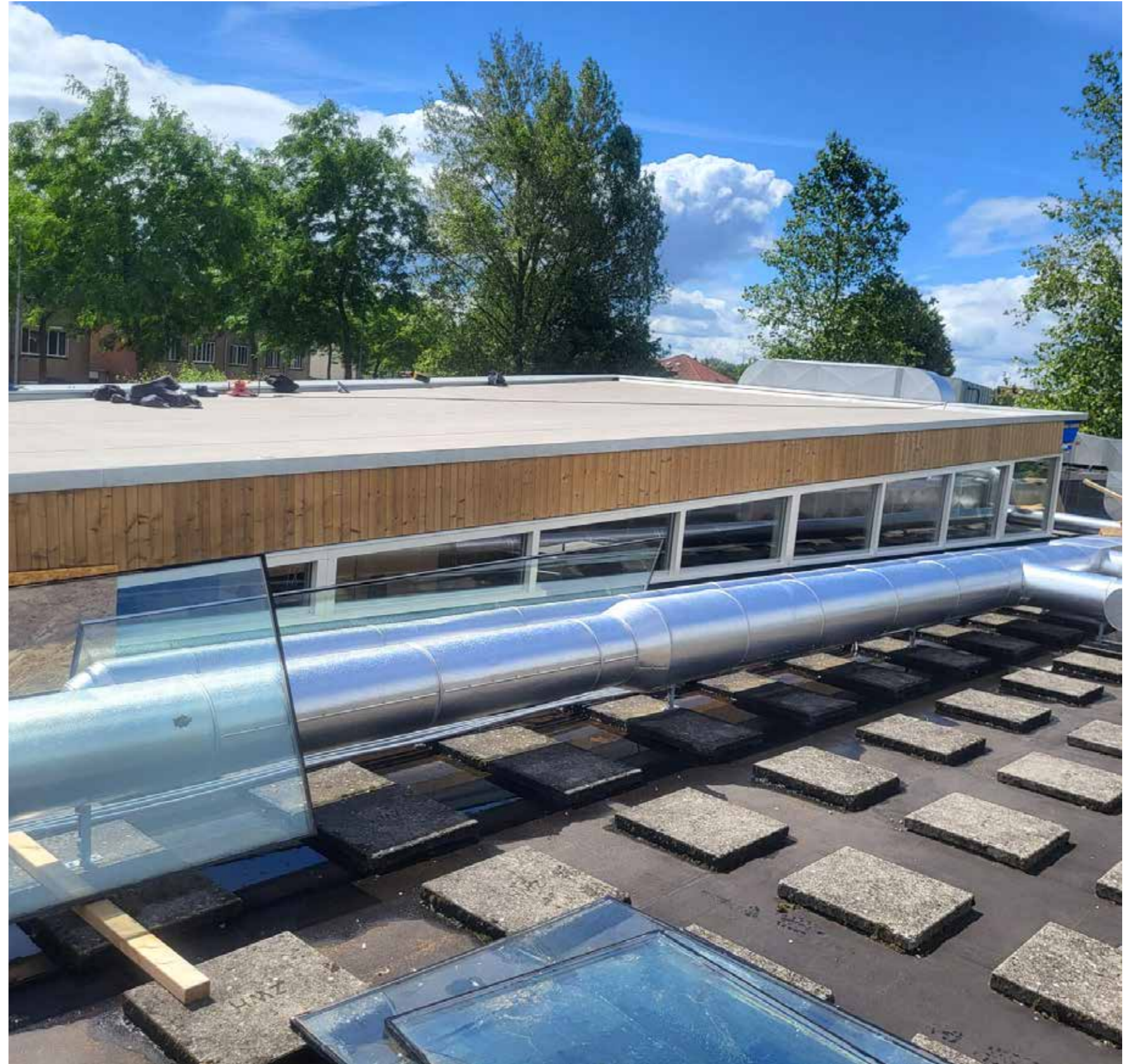
Basisschool Aurnyn: houten kozijnen vervangen voor nieuwe duurzame houten kozijnen - Zutphen
